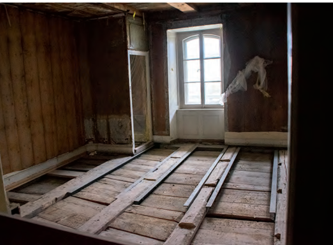
Bauleiterin Andrea Grob zeigt eine Sondierung zur Beurteilung der Tragstruktur.
